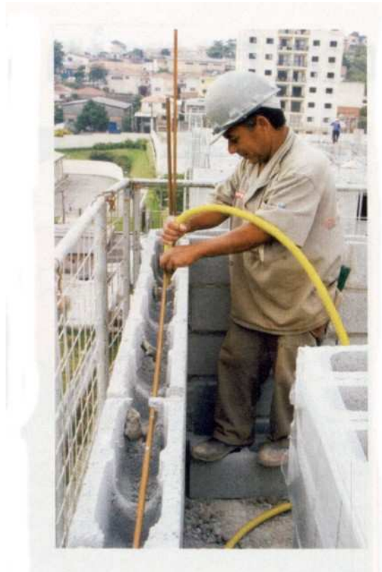
O reforço de concreto e ferro, horizontal e verticalmente fica embutido na alvenaria.
