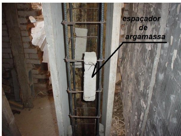
Quando a armadura do pilar estiver presa na broca, já com os espaçadores, “vestimos” a caixa com três faces. Daí então, fixamos a 4ª face.
