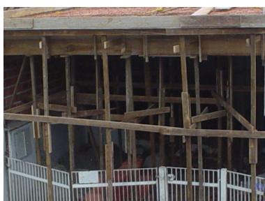
ESCORAMENTO DE MADEIRA
