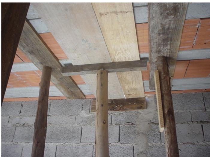
O escoramento por baixo da laje deve ser mais largo que a viga invertida de maneira a melhorar o engastamento entre as partes separadas.
