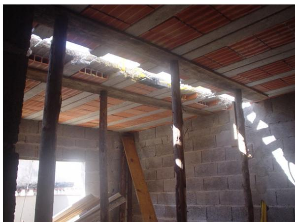
1º Passo: a laje em questão deverá ser escorada conforme a foto acima de maneira a desmembrá-la em duas deixando livre seu centro para que seja seccionada. A "cirurgia" só deverá ser realizada após o devido escoramento mantendo-se ainda o desnível encontrado. Este corte inicial visa expor a ferragem da treliça para, em seguida, serem cortados, de maneira a permitir a elevação das partes já separadas.
