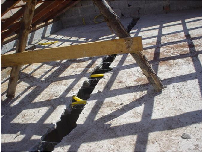
A estrutura do telhado que, às vezes, pode ser o causador do desnivelamento, deverá ser reposicionada de maneira a permitir a "cirurgia" da laje.
