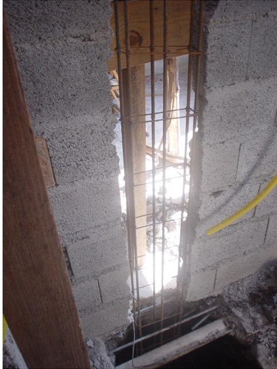
3º Passo: se tudo estiver ocorrendo de acordo será necessário definir as fundações dessa nova estrutura, geralmente consistindo de uma broca ou sapata armada que servirá de base para os novos pilares. Após a montagem das armaduras de viga e pilares, proporcionais aos vãos e espessura das paredes, devemos rasgar estas para que acondicione a nova estrutura de sustentação.
