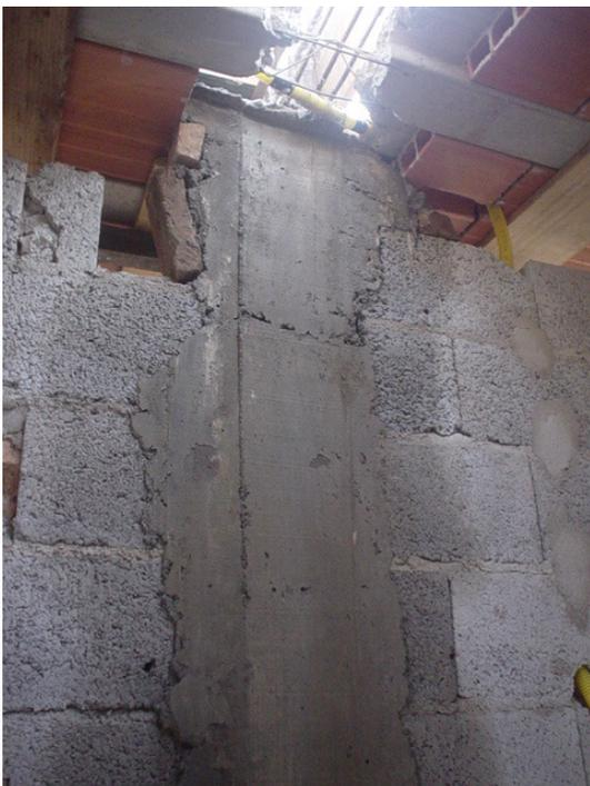
A concretagem do pilar deve ser executado em duas etapas para evitar a segregação dos materiais lançados de altura superior a 2 m.
