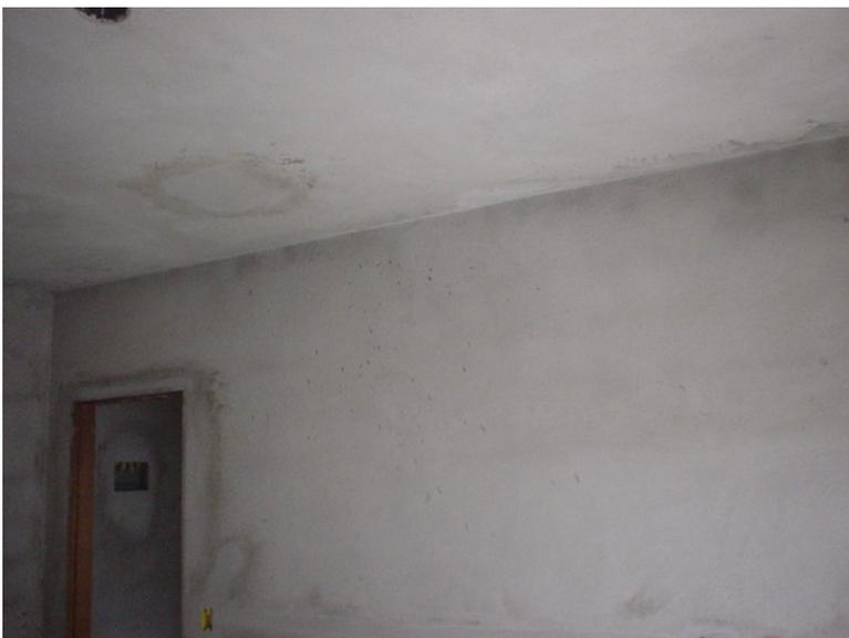
O revestimento argamassado ou de gesso encobre as estruturas auxiliares que foram executadas e, após a pintura, não revelará as atribulações causadas pelo incidente.
