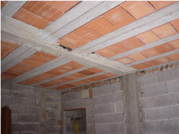
Após o tempo normal de cura do concreto os escoramento e formas podem ser desmontados. Se tudo correr bem a laje já esta pronta para o revestimento.
