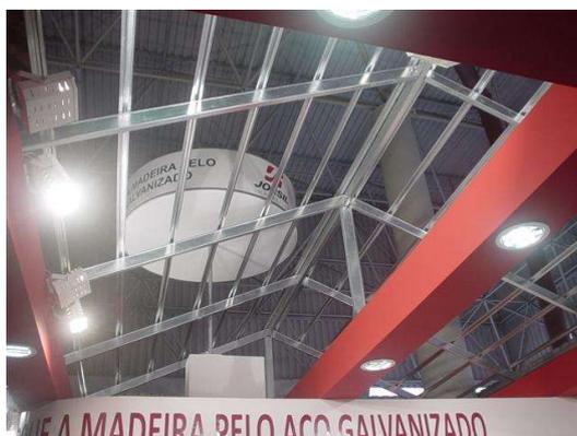
ESTRUTURA METÁLICA PARA TELHADOS
