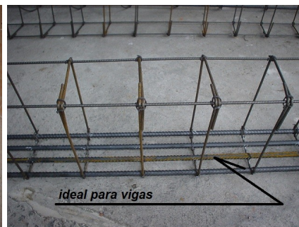
4 X 10 mm (embaixo) – 2 X 4.2 mm (em cima) – estribos c/ 15 cm
